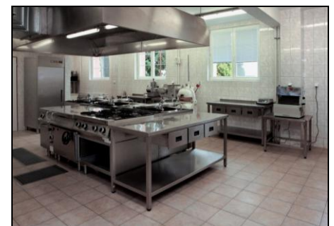
KUCHYNĚ PO REKONSTRUKCI
